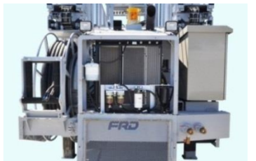
後部点検箇所(カバーOPEN)
